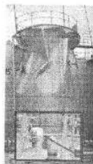
شکل ۳-۱. کمانش مخزن در اثر فشار خارجی باد
