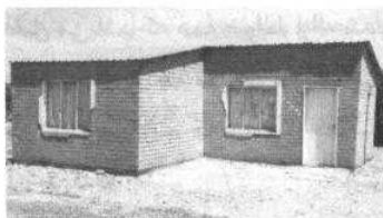
ساختمان آجری غیرمسلح
