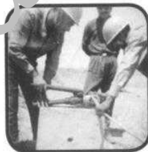
گروه نوسازی در حال پوشش زدن سیستم شبکه
