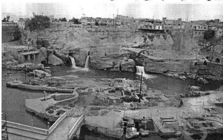
سازه‌های آبی (آبشارها) - شوشتر ۲
